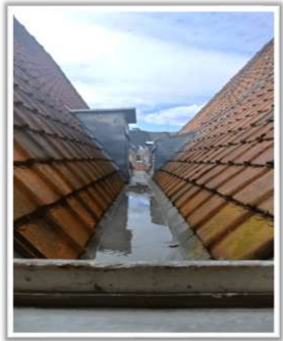
Figure 43 - Entre les toits.
