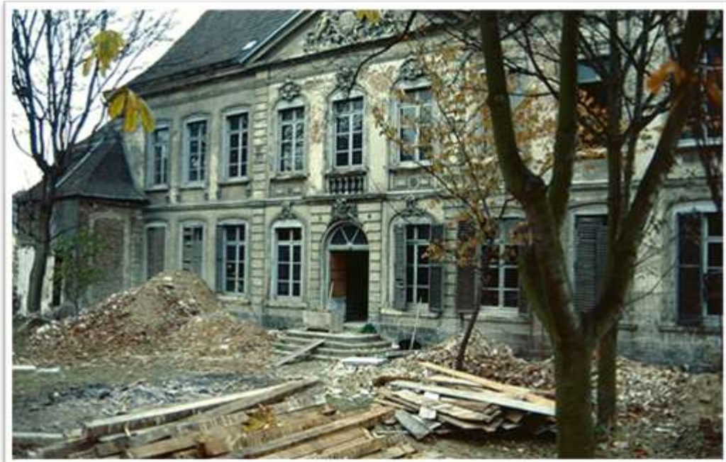
Figure 51 - Le côté ardin en 1986 – Début des travaux
