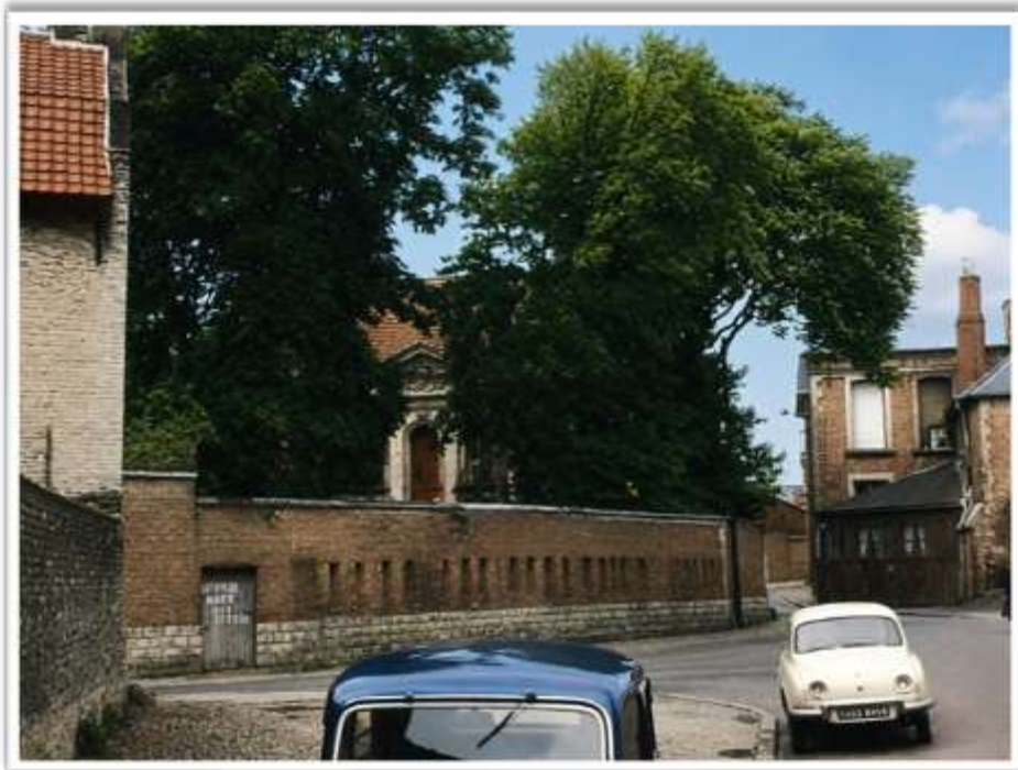
Figure 54 - Vue depuis le sud du jardin.
