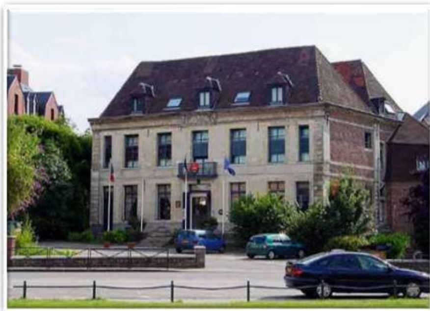
Figure 35 - Façade côté place Saint-Amé en 2004
