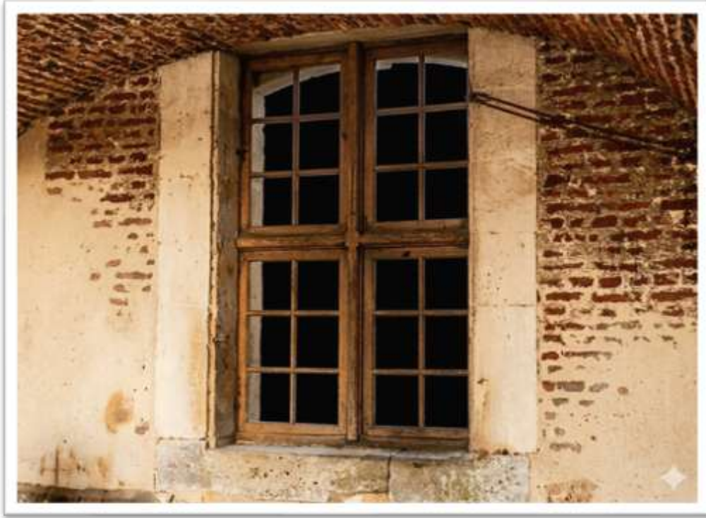
Figure 56 – Une fenêtre dans une cave.
