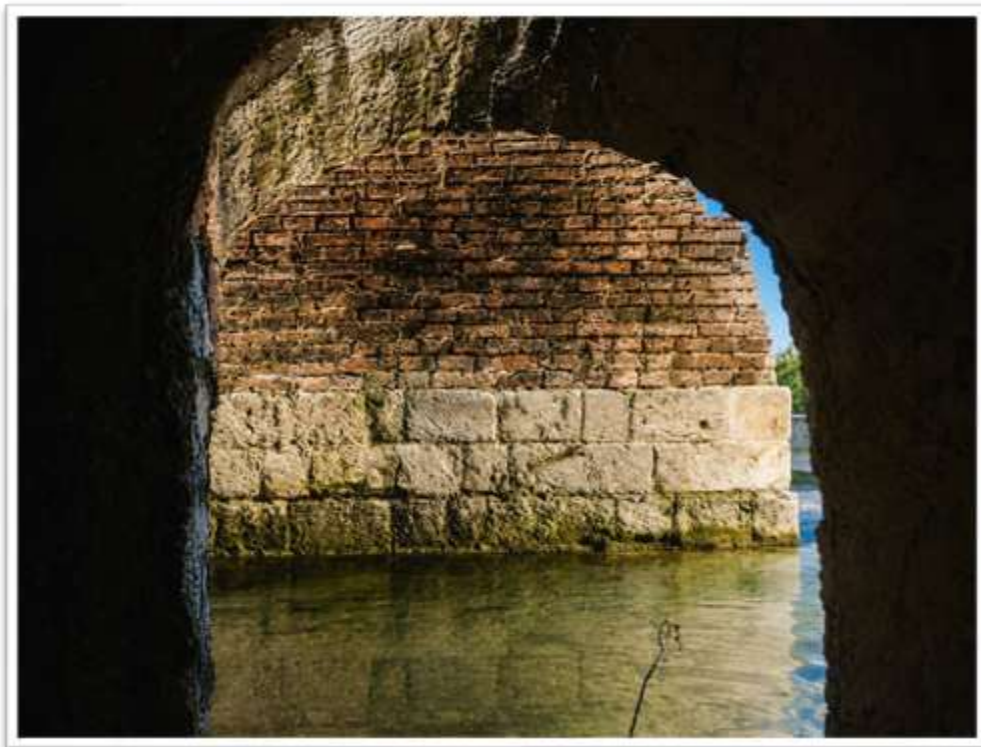
Figure 55 « Le courant » qui passe sous la maison.
