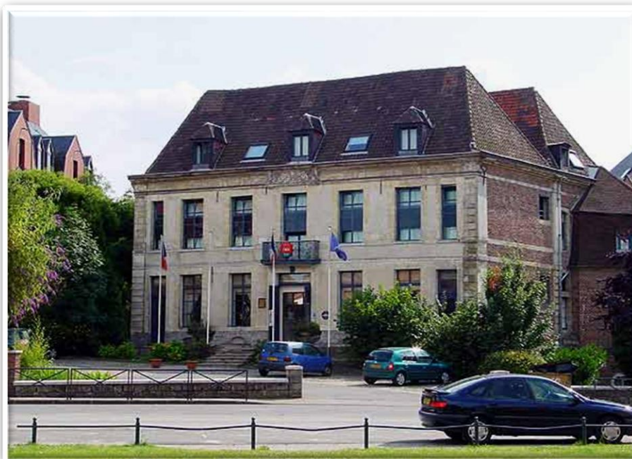
Figure 36 - Façade côté place Saint-Amé en 2004
