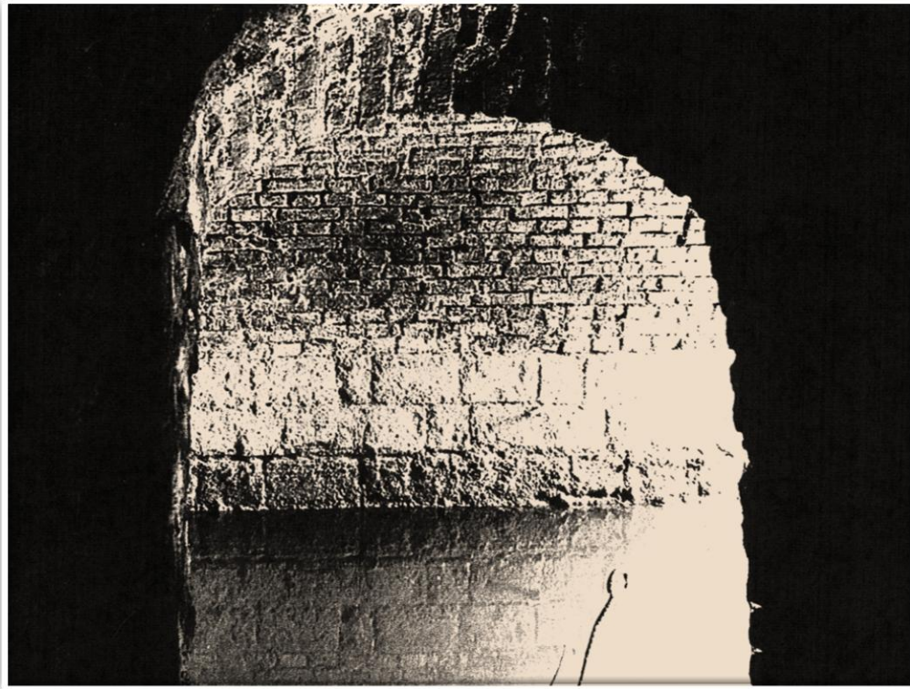
Figure 52 - « Le courant » qui passe sous la maison
