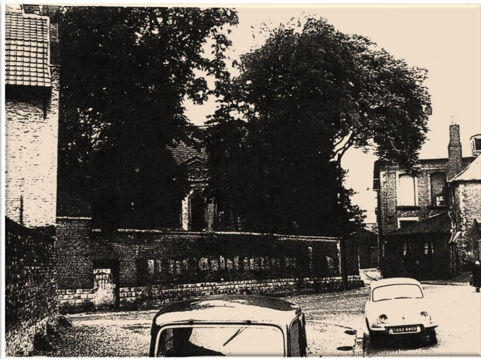
Figure 50 - Vue depuis le sud du jardin. L'inscription « MORT AUX VACHES », que nous avons connue, est encore visible en 1980 sur la petite porte basse en bois !
